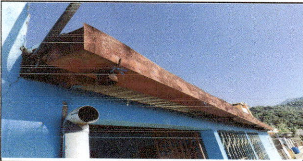
Sustitución de canal de metal
